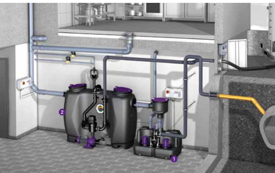
1 Estação elevatória 2 Separador de gorduras EasyClean
