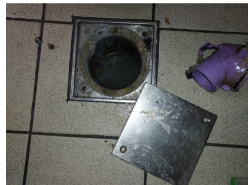
Corpo de sifão, com sifão removível na descarga e acessórios de conexão
