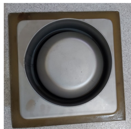
Reforço interior do aro com resina sólida
