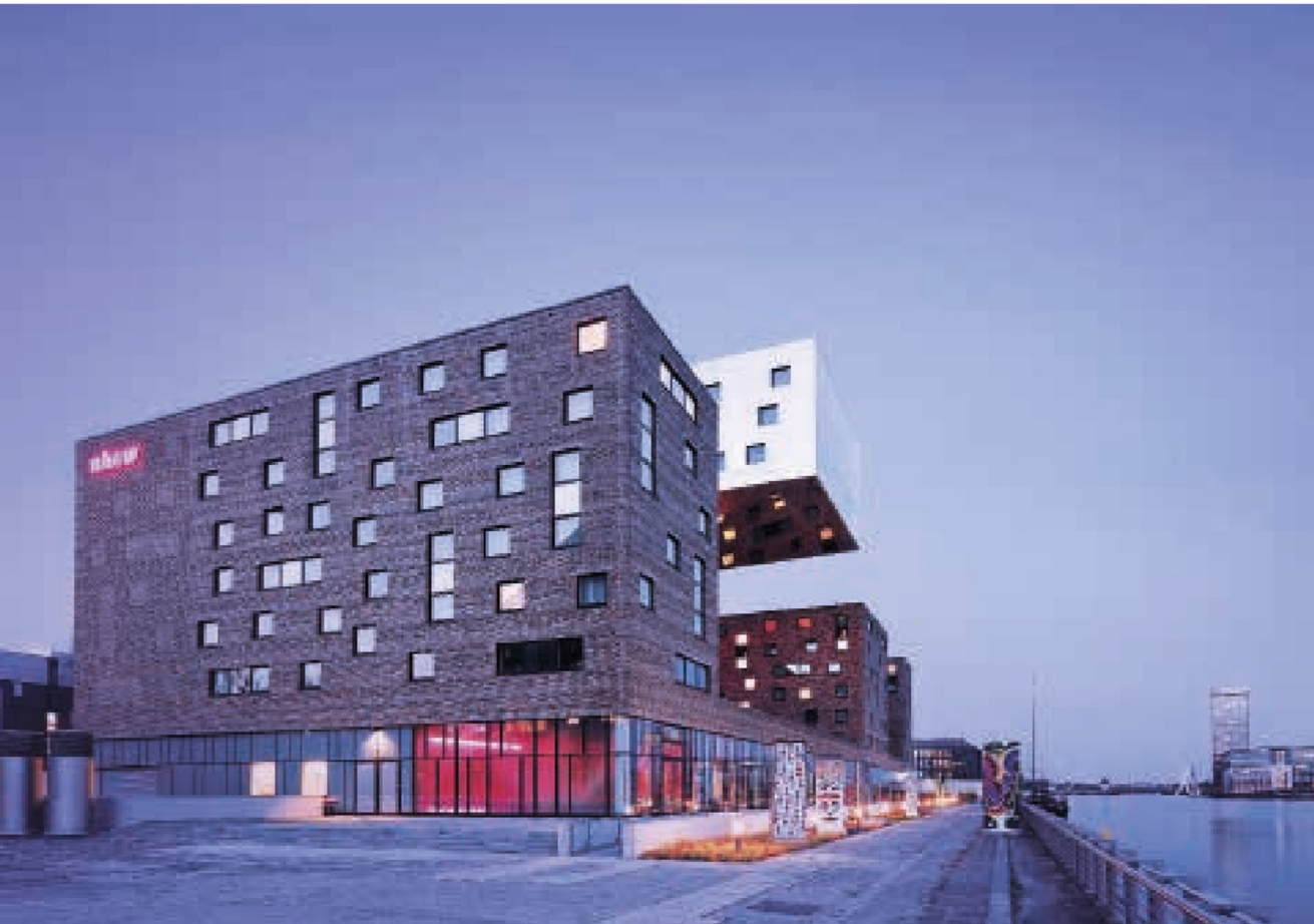
Em grandes hotéis, como o nhow Hotel Berlin, centenas de pontos de drenagem são utilizados de diferentes formas.
