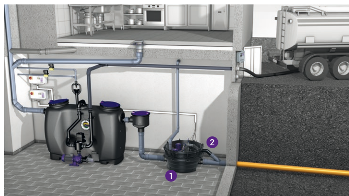
1 Estación elevadora híbrida 2 Tubería de presión
